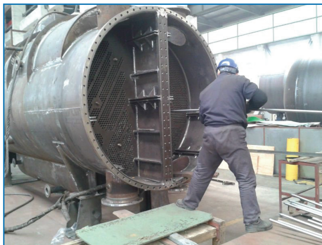
Рисунок 2. Чистка внутренних поверхностей конденсатора паровой турбины.
